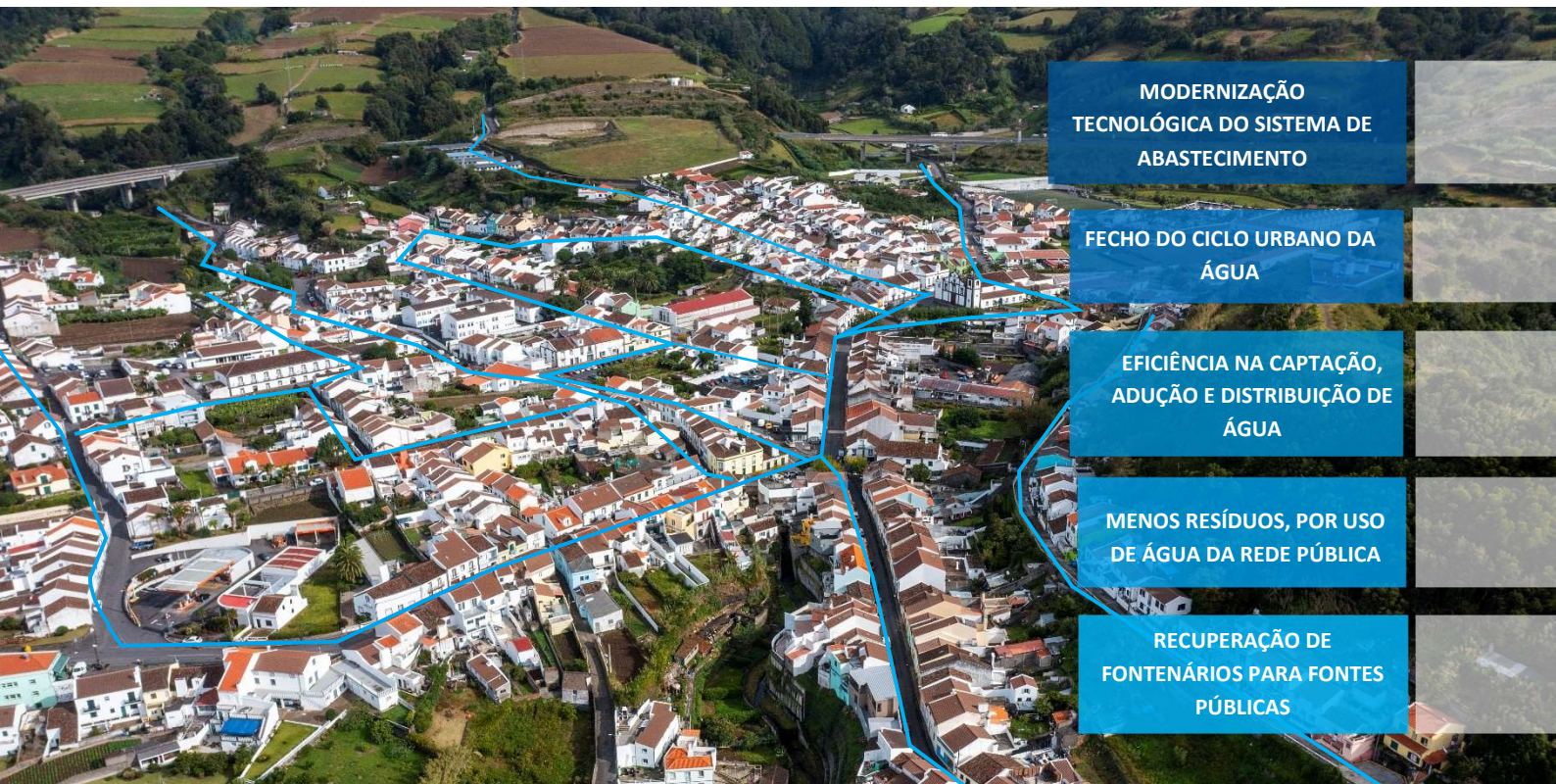
Vista aérea – Vila de Água de Pau
